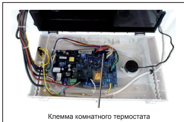
Рис. Подключение комнатного термостата
