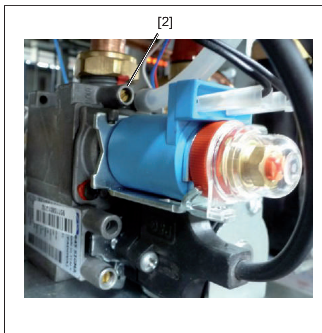
Рис. Штуцер для измерения давления в сопле
